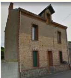
Maison de bourg avec encadrements des ouvertures en brique et un traitement ornemental de la corniche
