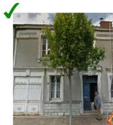
Rénovation de la façade en accord avec l'aspect originel de la construction
