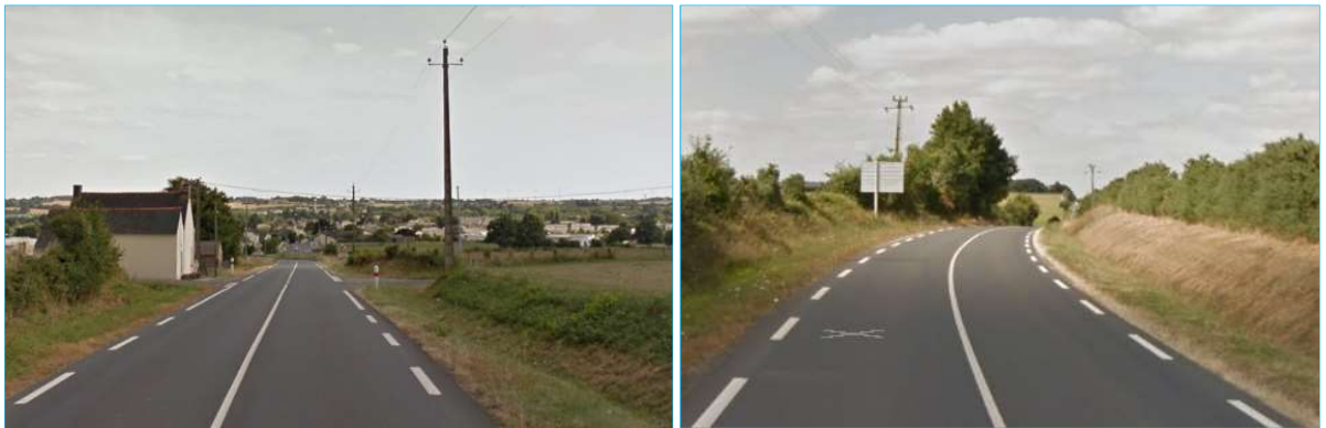
Entrée et sortie nord de Saint-Mars-la-Jaille
