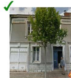
Rénovation de la façade en accord avec l'aspect original de la construction
