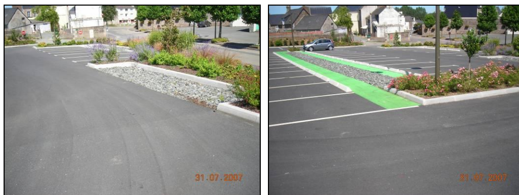
Photo 4 : Exemple de tranchées drainantes
