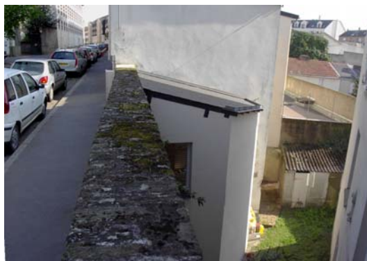
Remblai dans le lit majeur au pont St Mihiel
