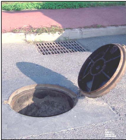
▶ Puits d'infiltration sur voirie (à éviter)
