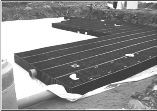
▶ Système D-Raintank® Chantier à Vannes
