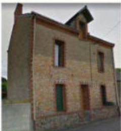
Maison de bourg avec encadrements des ouvertures en brique et un traitement ornemental de la corniche
