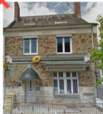
Suppression des volets traditionnels sur le bâtiment de La Poste
