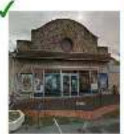
Rénovation maladroite de la façade (2018)
