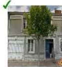
Rénovation de façade en accord avec l'apparence originale (2018)
