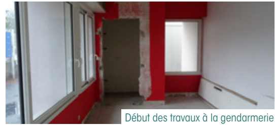
Début des travaux à la gendarmerie
