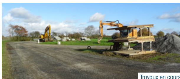
Travaux en cours
