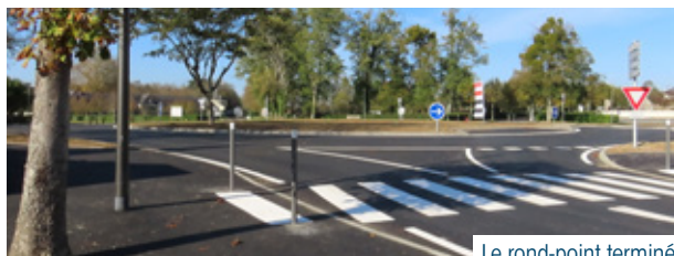
Le rond-point terminé
