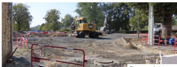
En cours de travaux
