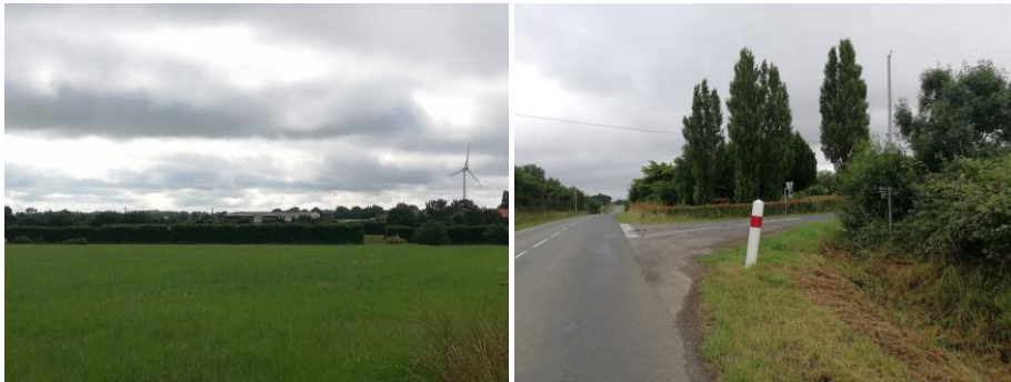
4 Entreprise Chauviré depuis la RD28 (© Territoire+)
