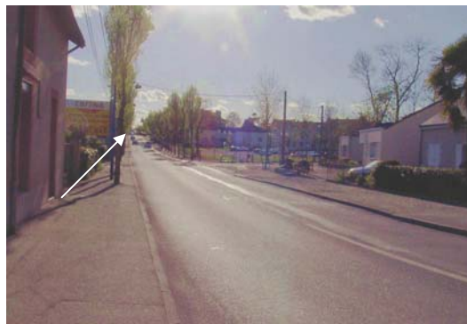
Vue de la RD 16 vers l'ouest. On remarque nettement le talus en arrière plan, qui limite la plaine alluviale fonctionnelle.
