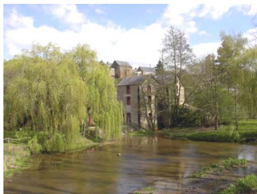
Un ancien moulin sur l'Erdre à Bonnœuvre
