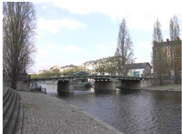
L'Erdre dans la traversée de Nantes
