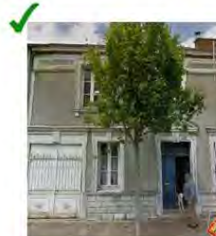
Rénovation de la façade en accord avec l'aspect original de la construction
