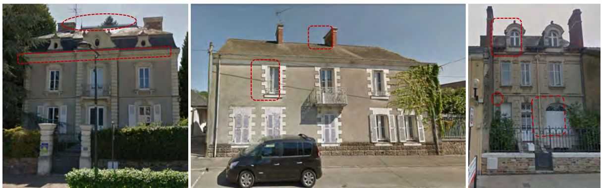
Exemples de bâtis traditionnels du centre-bourg historique de Saint-Mars-La-Jaille
