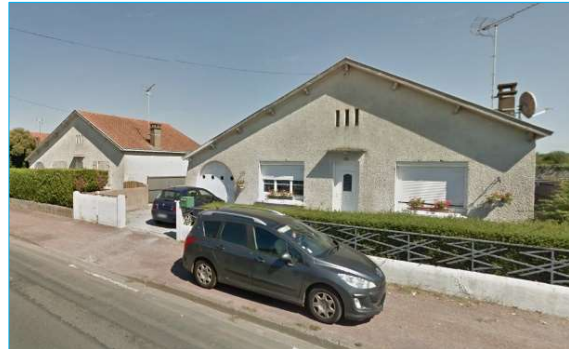
Maison ouvrière - rue d'Ancenis
