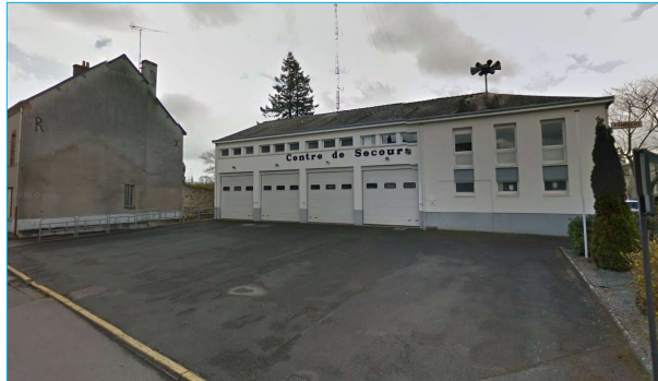
Centre de secours - rue Neuve
