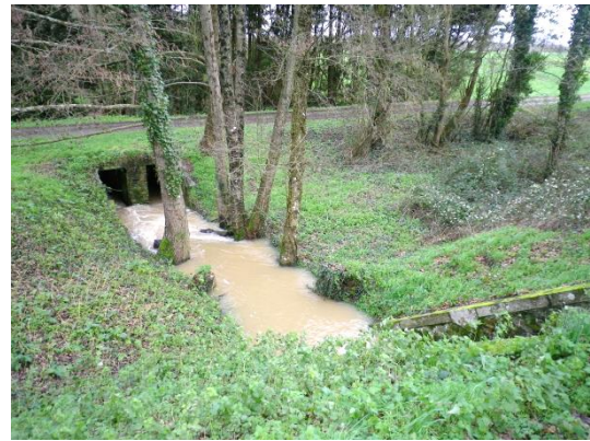
L'ouvrage 3, sous le chemin de terre (vue depuis l'ouvrage 2)
