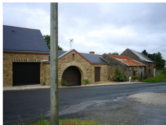
Bâtiment réhabilité aux Hautes Provostières
