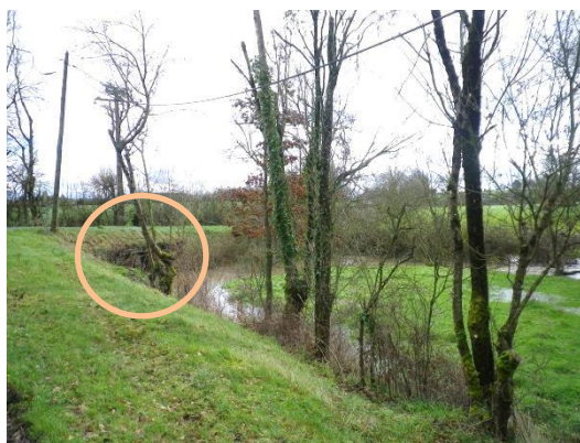
L'ouvrage 1, sous voirie routière
